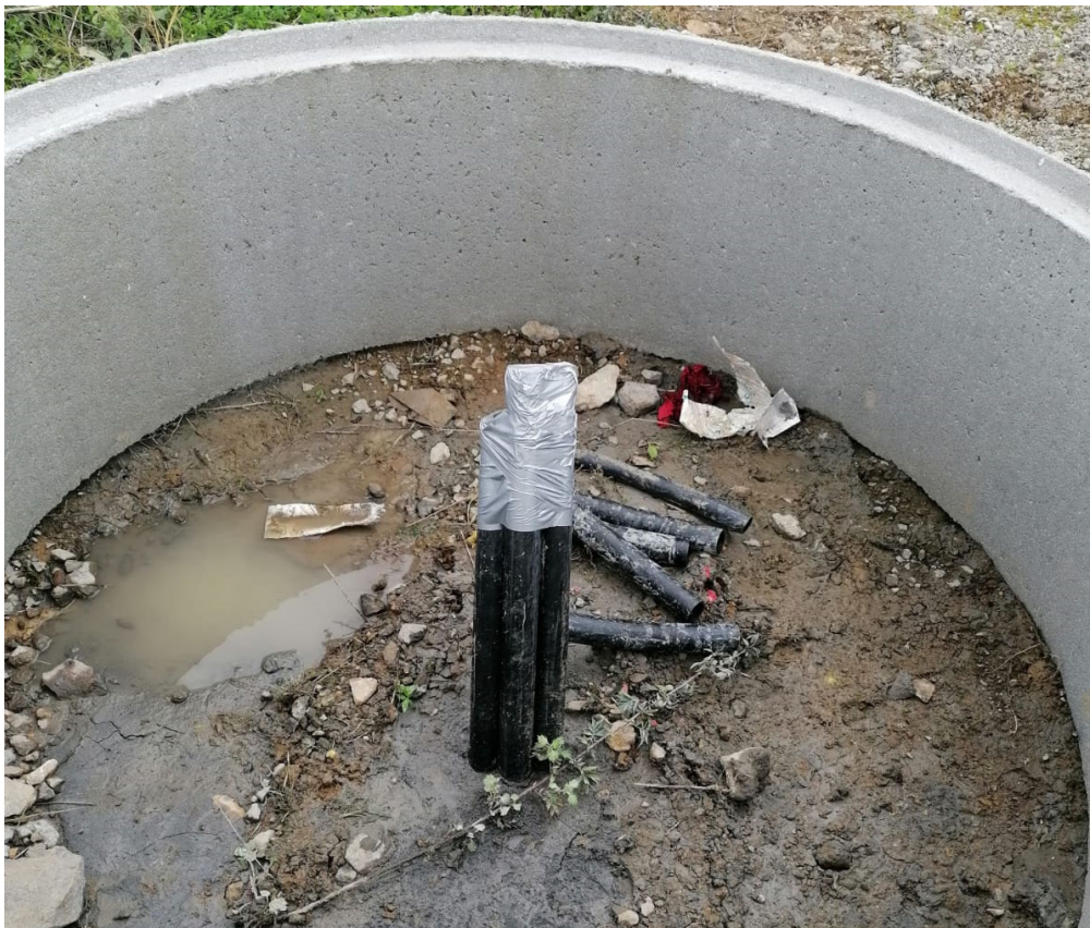
Foto 2: Erdwärmesonde EWS 1 nach Abbau des Geothermal Response Tests
